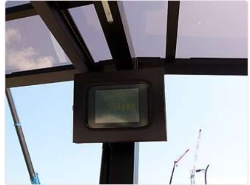
①シェルター（シースルーの太陽電池モジュールが一体化したシェルター）
